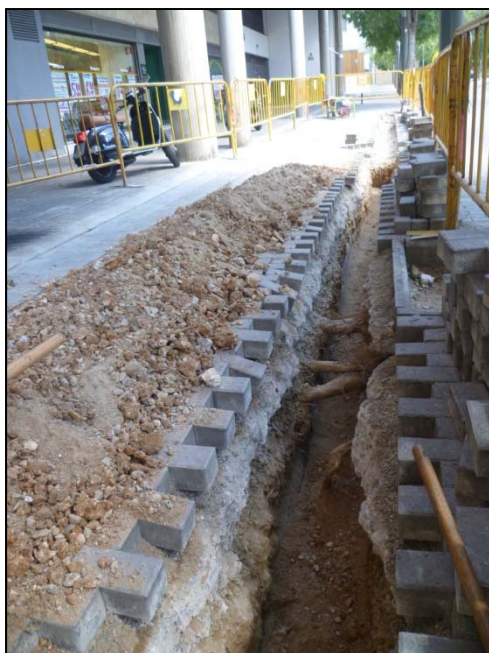
Fotografia 2. Vista de la Rasa 100 al tram del parc de la Font Florida.
