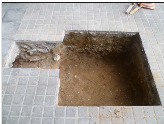
Fotografia 4. Sondage realitzat a la cruïlla del parc de la Font Florida i la Gran Via de les Corts Catalanes.
