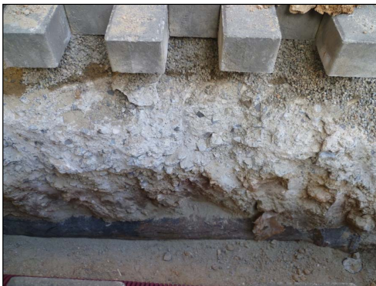
Fotografia 6. Vista de la Rasa 100 en el tram de la Gran Via de les Corts Catalanes on s'observen alguns serveis.
